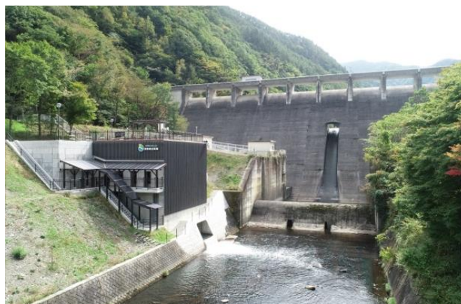
既存ダムに発電施設を新設した設置例 (長野県企業局 横川蛇石発電所)
