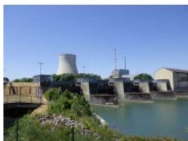
ダム直上流の 左岸のクーリ ングタワーは 原子力発電所
