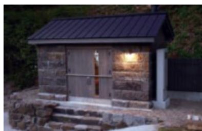
農村風景と調和した石積みの発電所建屋
