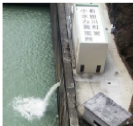
県の多目的ダムの維持流量放流水を利用
