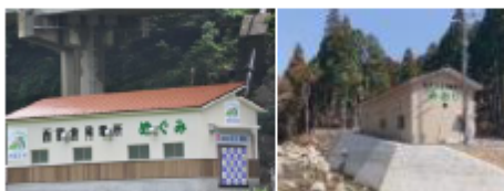
西粟倉発電所(左)、西粟倉第2発電所(右)
