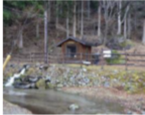
森林公園に設置された木造の発電所建屋
