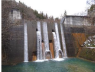
県の砂防堰堤を取水に利用
