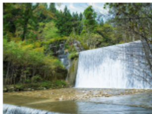
県の砂防堰堤を取水に利用
