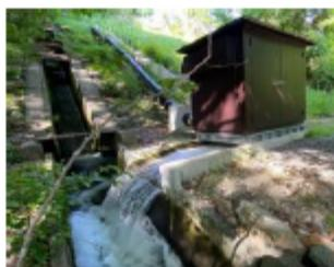
発電機・建屋一体型の小水力発電システム
